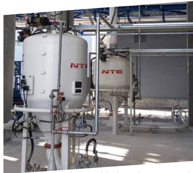
Tipico sistema di trasporto pneumatico in fase densa con Propulsori M201
